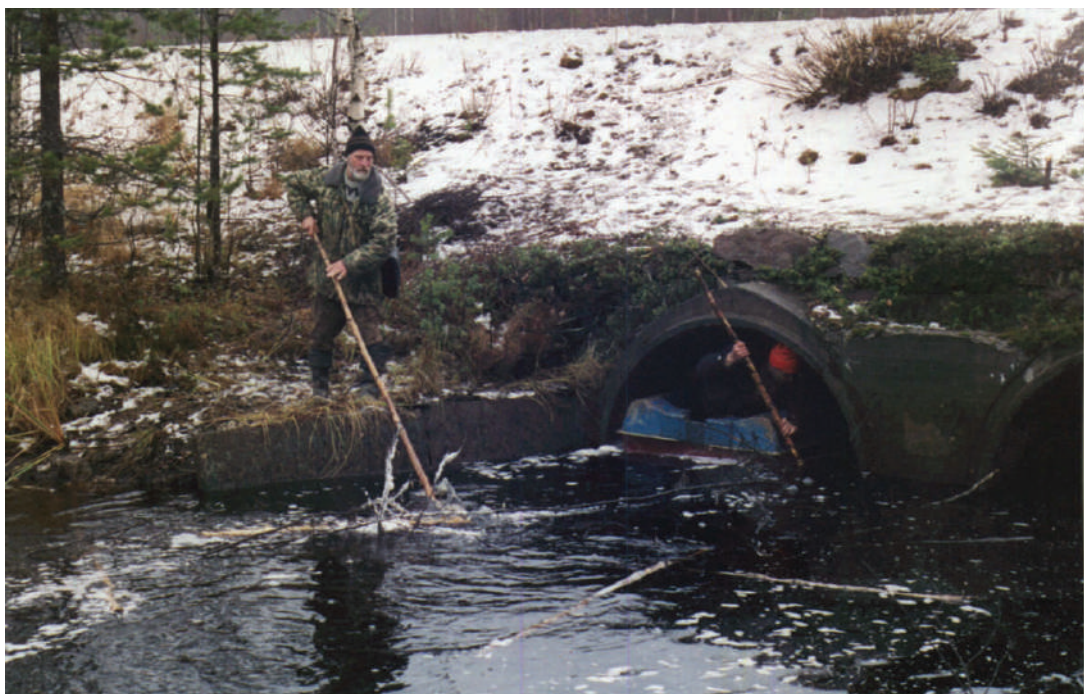
Фото 22. Костомукшский заповедник. Очистка дорожной трубы от плотины. Фото Ф.В. Фёдоров.
