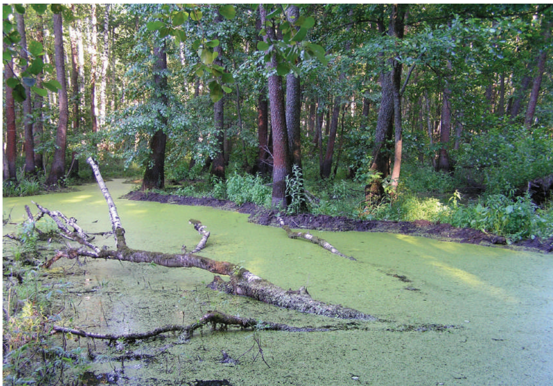
Фото 57. Окский заповедник. Плотина, перегораживающая старицу Пры (Смолянка) на две части.
