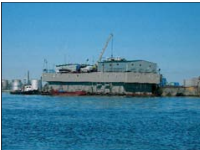
Рис. 267. Основные линии разделочно-морозильного оборудования и часть производственных и жилых помещений ООО «Роял Стэйт» смонтированы на плавучей платформе (июнь 2006 г.)
