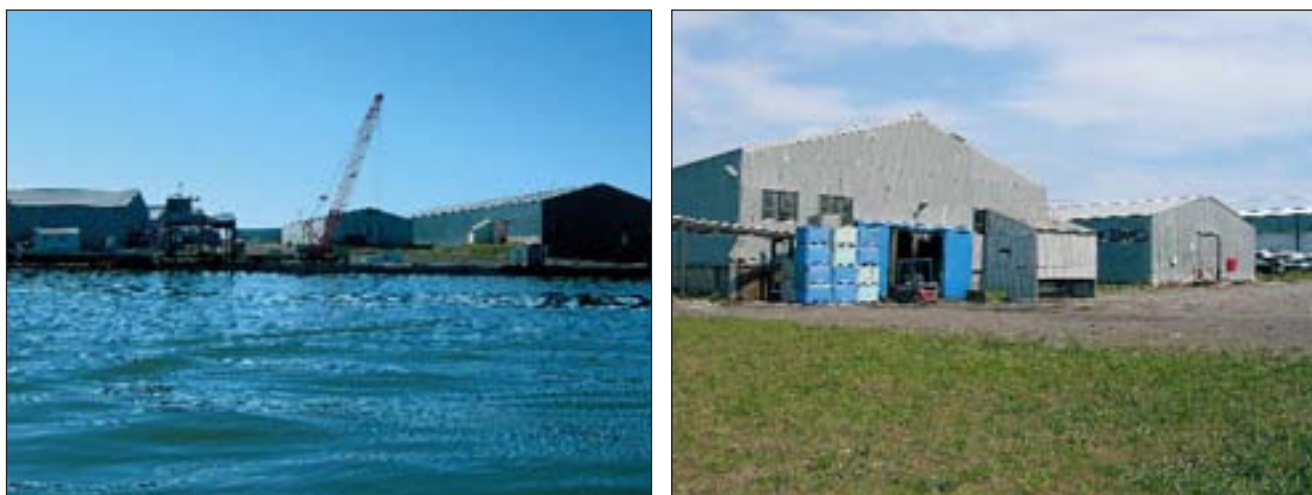
Рис. 262. Приемная пристань для разгрузки рыбы, морозильный цех, холодильник и складские помещения – ООО «Устькамчатрыба» (июнь 2006 г.)
