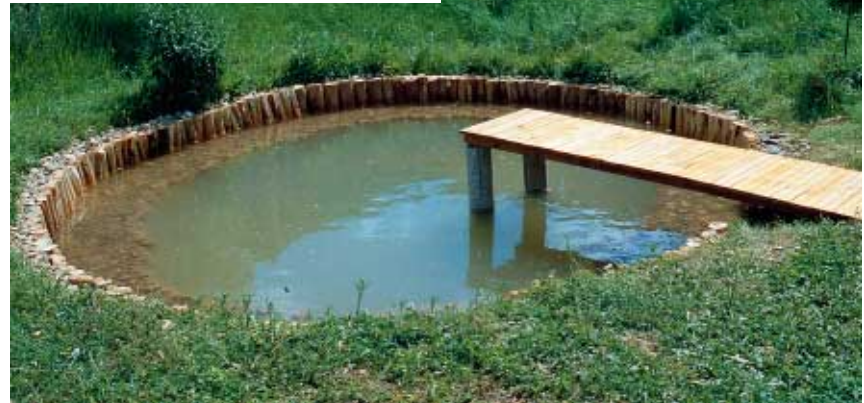
Второй этап строительства водоёма
