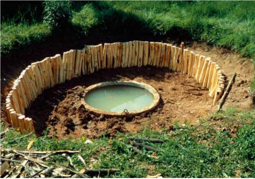
Первый этап строительства водоёма
