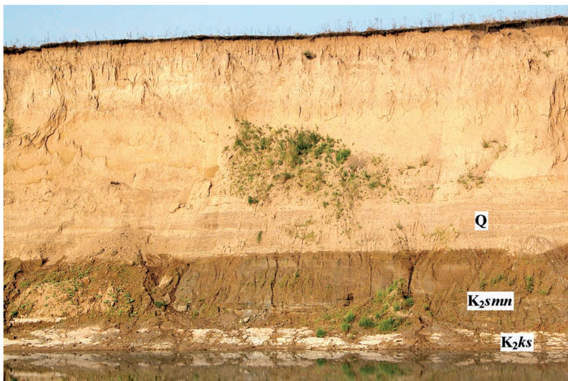
Рис. 3.14. Обнажение 16, Кубаево, выходы кийской ( K_2ks ) и симоновской ( K_2smn ) свит перекрываются мощной толщей четвертичных пород (Q).
