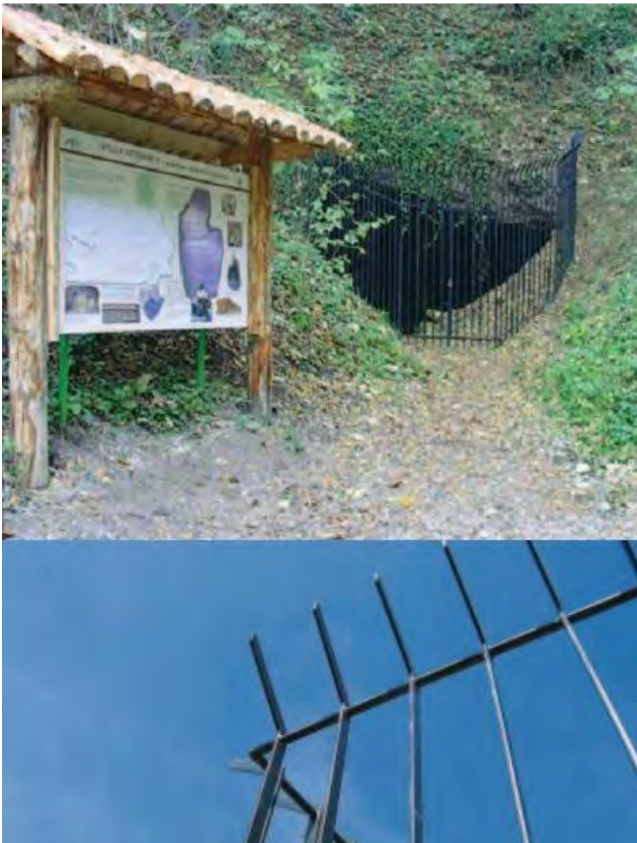
Рис. 65. Огороженная штольня, Хорватия (верхнее фото). Верх ограждения, Португалия (нижнее фото) (Митчелл-Джонс и др., 2011). Fig. 65. Fenced gallery, Croatia (top photo). Top of the fence, Portugal (bottom photo) (Митчелл-Джонс и др., 2011).
