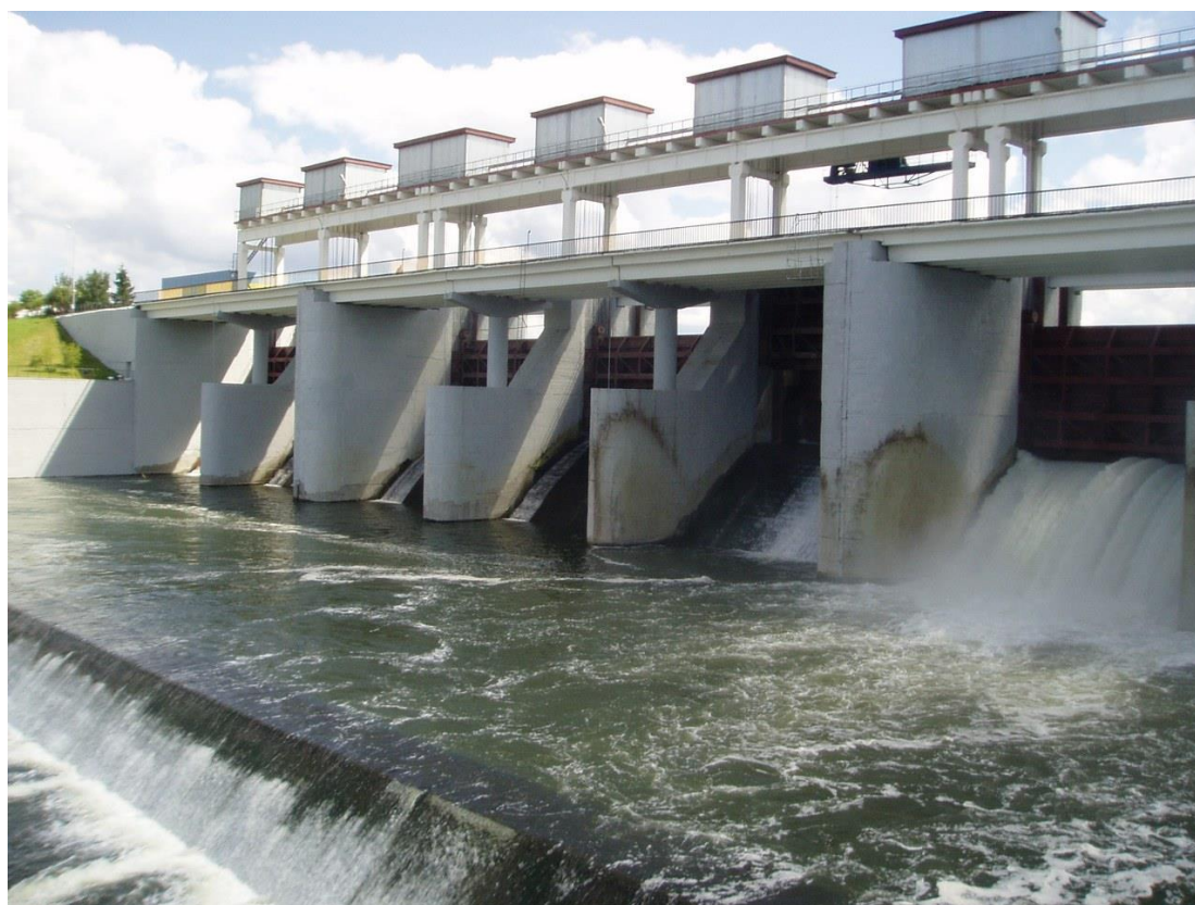
Рис. 39 Плотина Пензенского водохранилища
