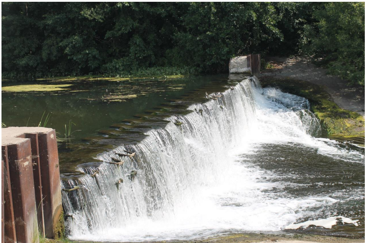
Рис. 41 Плотина на р. Хопер. Колышлейский район
