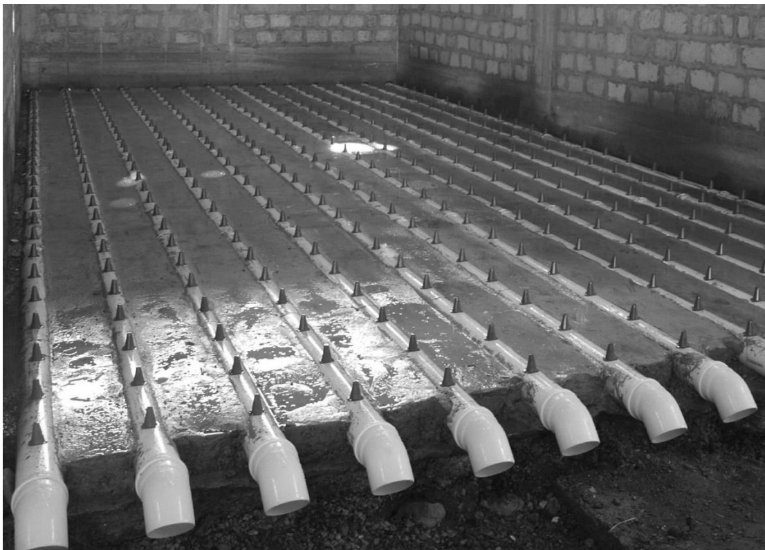
Рис. 37 Пол с системой форсунок
