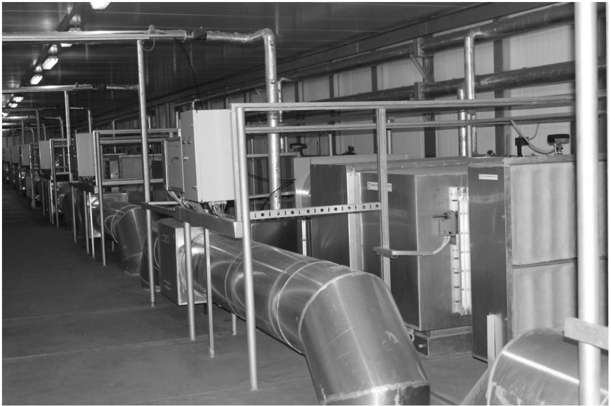
Рис. 50 Система подачи и охлаждения воздуха
