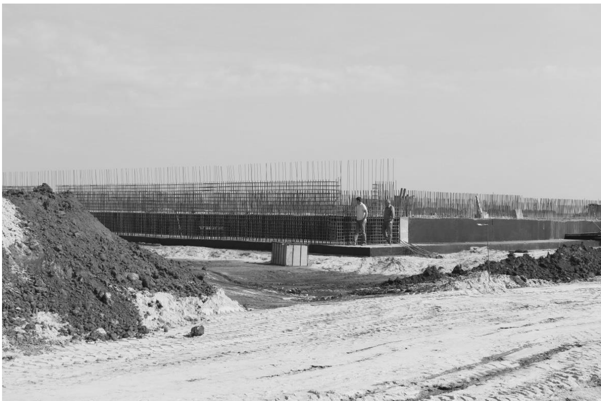
Рис. 34 Армированный фундамент для бункеров
