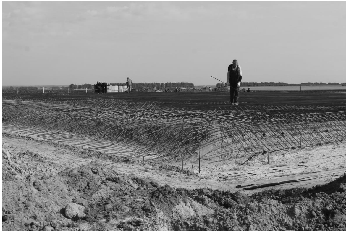
Рис. 40 Армированный фундамент для тоннелей
