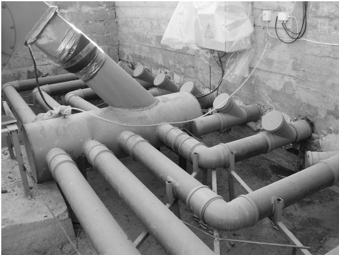
Рис. 36 Система подачи воздуха
