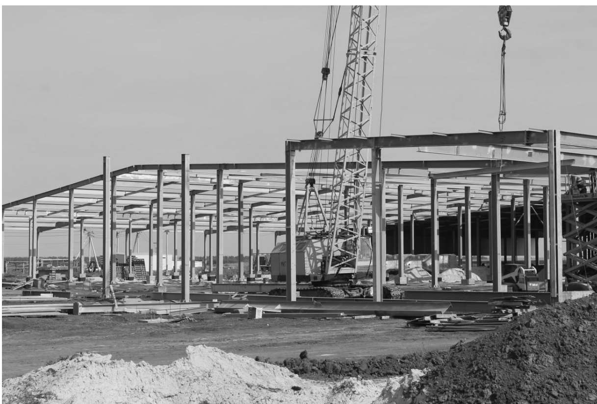
Рис. 44 Металлический каркас здания
