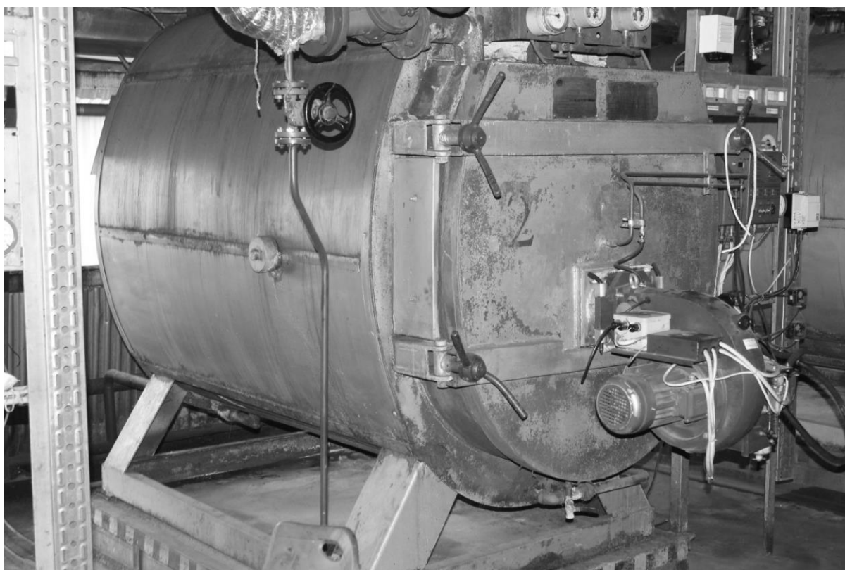
Рис. 49 Отопительный котел с паро-образователем
