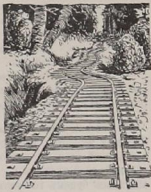
Рис. 87. Прямая линия желѣзнодорожной дороги, изогнувшаяся вследствие «сдвиговъ» при землетрясеніи въ Остѣ-Иллиіи.
