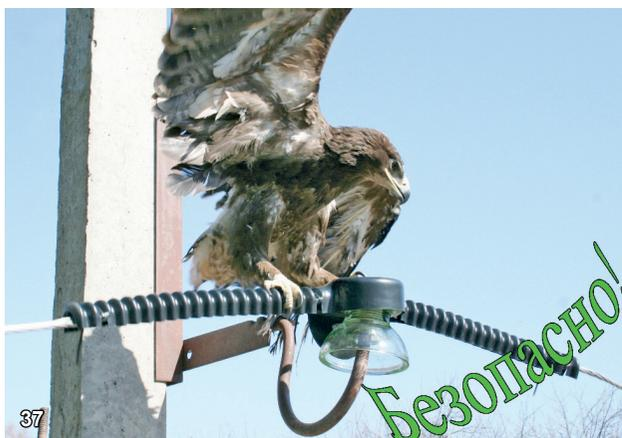
струкциях опор ЛЭП рекомендуется использовать антиприсадные устройства в виде искусственных заграждений, выполненных с использованием композитных диэлектрических (полимерных, стеклопластиковых и др.) материалов (эти устройства не являются птицевозитными! Они должны устанавливаться наряду с ПЗУ).
