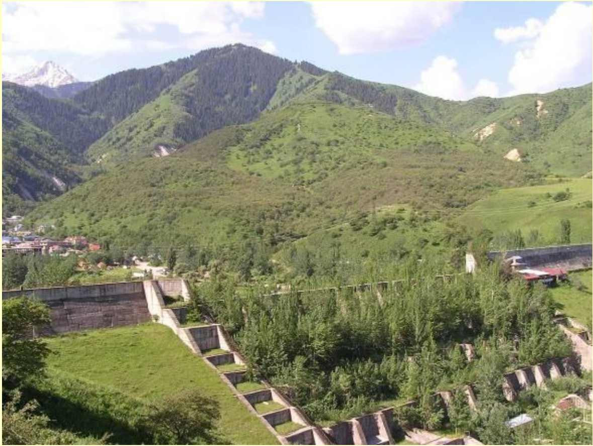
Вид на плотину с северной стороны
