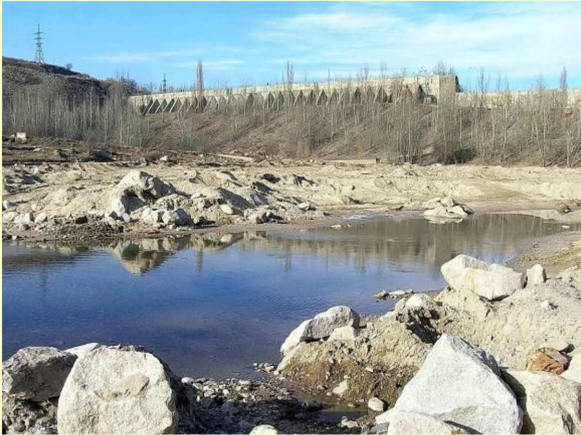
Селезащитная плотина в Большом Алматинском ущелье
