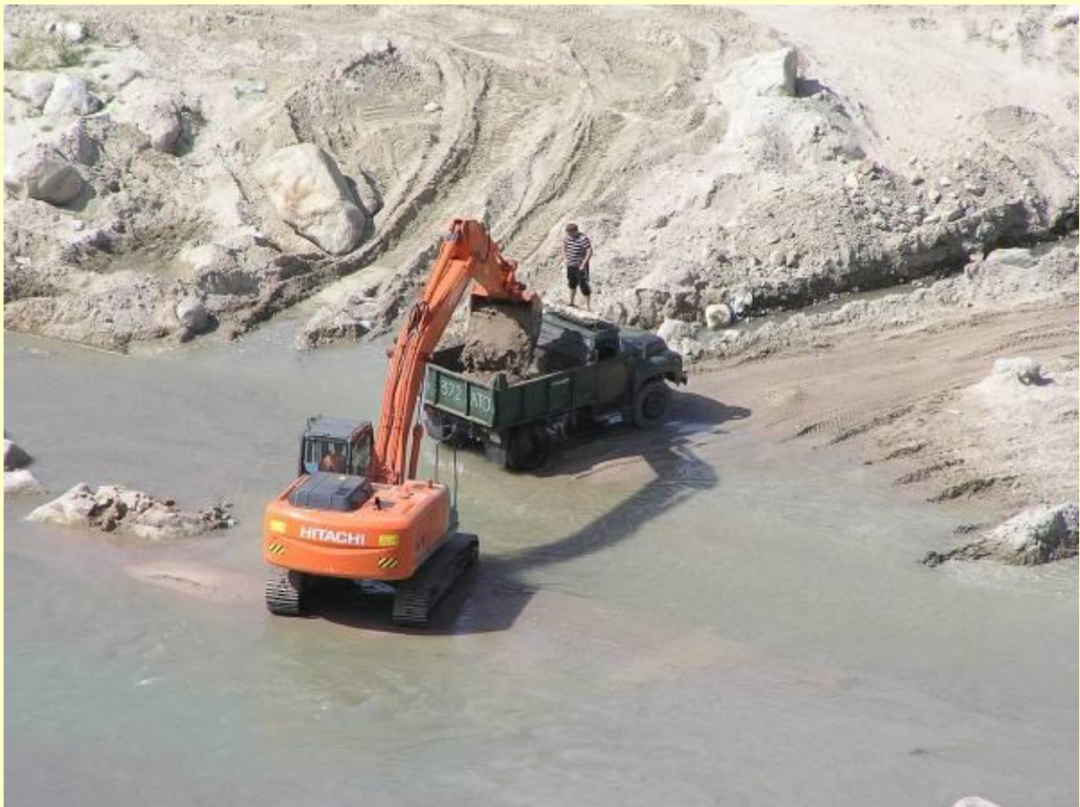
Углубление селехранилища перед плотинной
