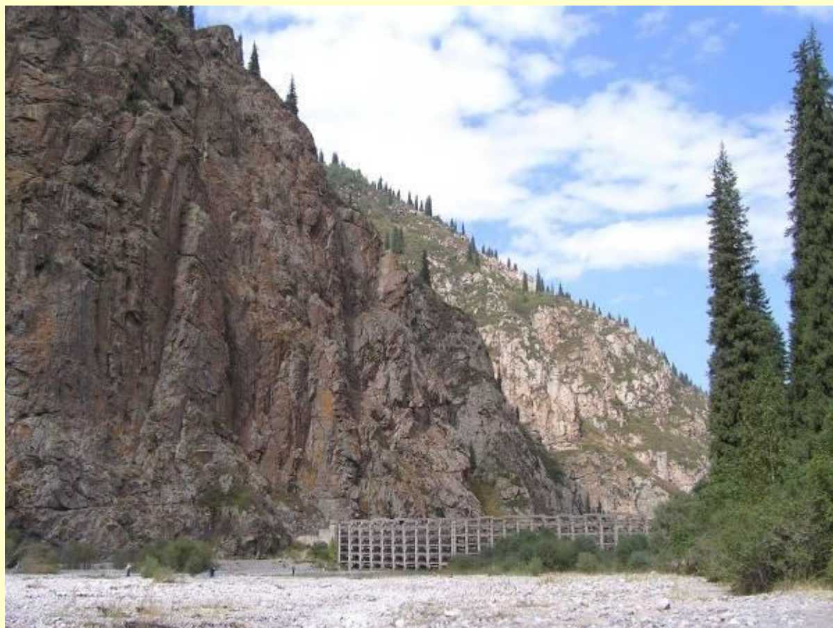
«Кремлевская стена» и селезащитная железобетонная ловушка
