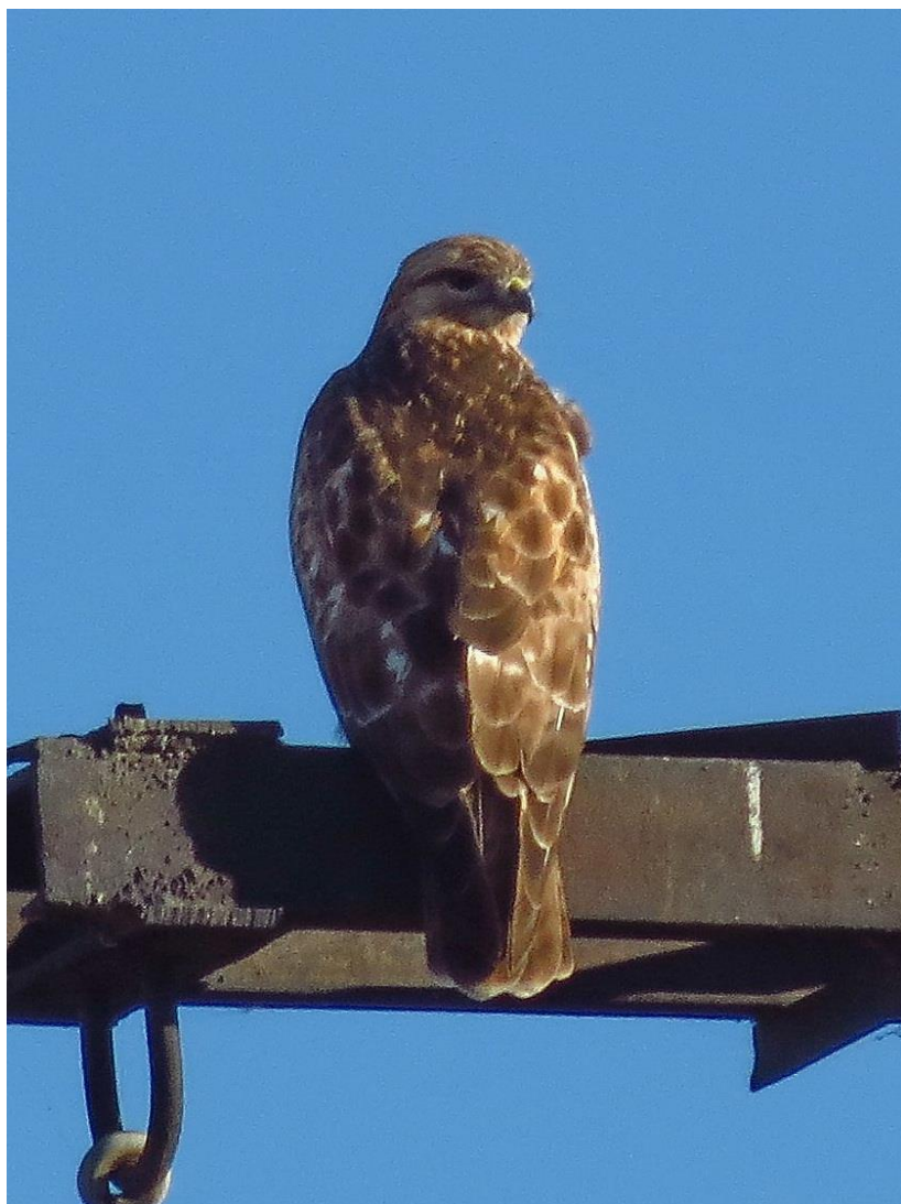
Обыкновенный канюк Buteo buteo на опоре ЛЭП. Микрорайон Нур-Алатау, 09.11.2017.
