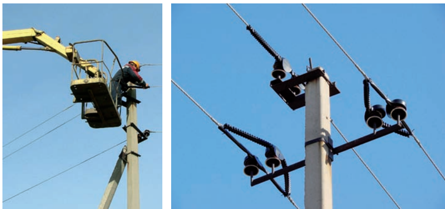
Илл. 71. Установка ПЗУ 6—10 кВ-Д производства ООО «Эко-НИОКР» (Ульяновск) в Новоспасском районе
