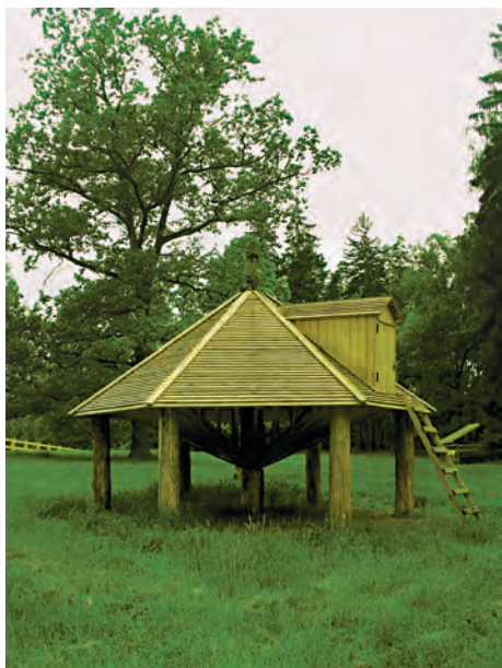
Отремонтированная царская зубровая кормушка, которой 107 лет
