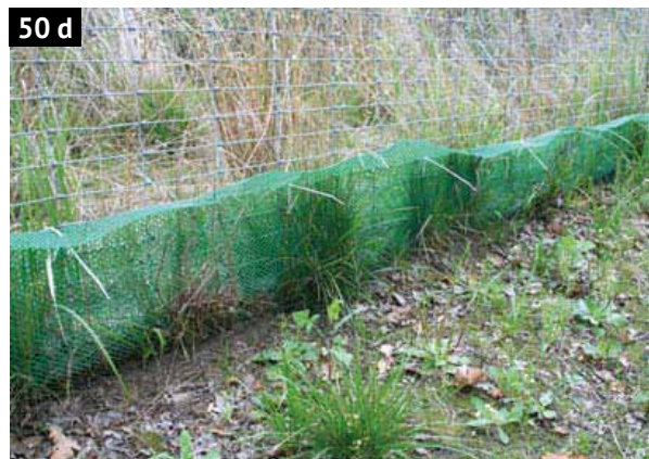
Фото 50а, b, c, d. Експансія рослинності за неналежного обслуговування огорож (різних типів)
