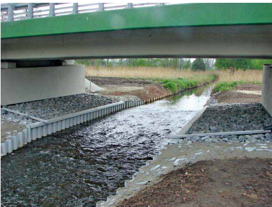
Фото 5. Неправильне укріплення водотоків заважає руху земноводних каналами та вздовж них
