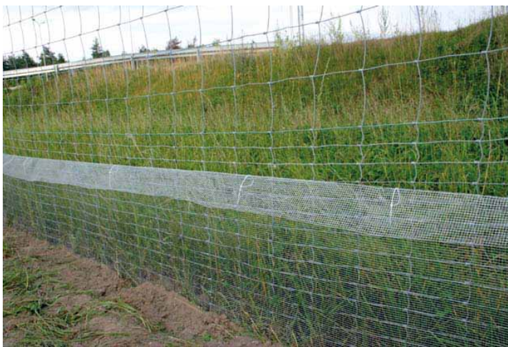
Фото 21. Захисна огорожа із металевої сітки
