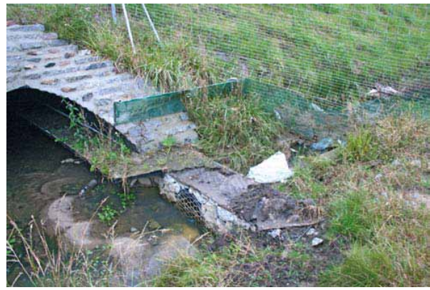
Фото 92. Полиці з габіонів часто створюють проблеми з відповідним та постійним покриттям їх поверхні
