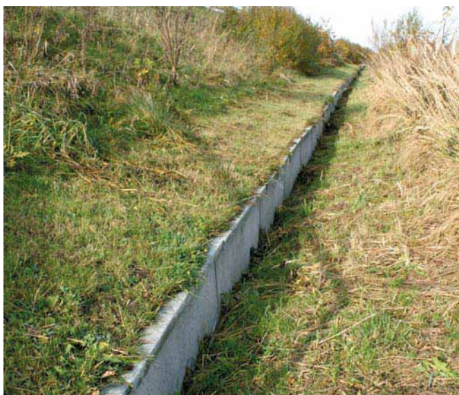
Фото 12. Огорожа з суцільних плит, вбудованих у проміжний насип
