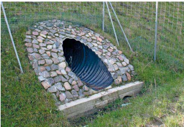
Фото 91. Бетонний поріг суттєво заважає амфібіям потрапляти до проходу
