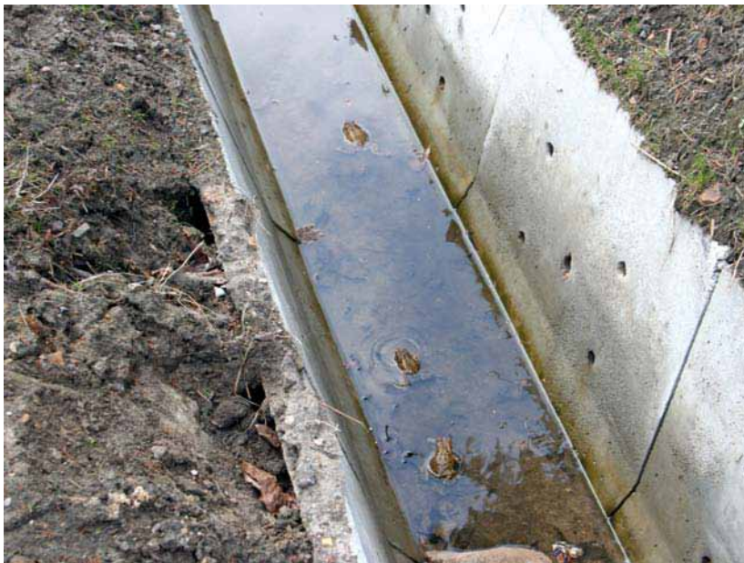
Фото 10. Земноводні, ув'язнені в рові, укріпленому бетонними жолобами (т.зв. «краківськими коритками»)
