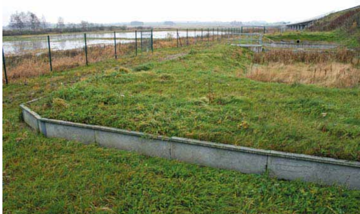
Фото 17. Огорожа з твердих панелей навколо дренажних споруд
