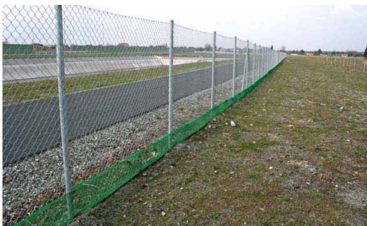
Фото 18. Огородження водозбірника за допомогою полімерної сітки
