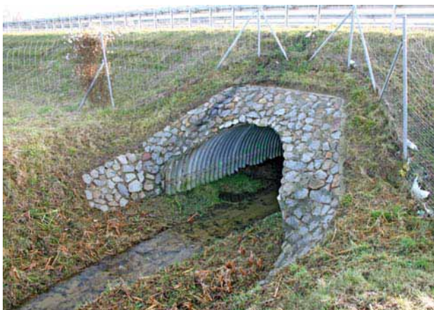
Фото 80. Еліптична металева пропускна труба з наземними полицями
