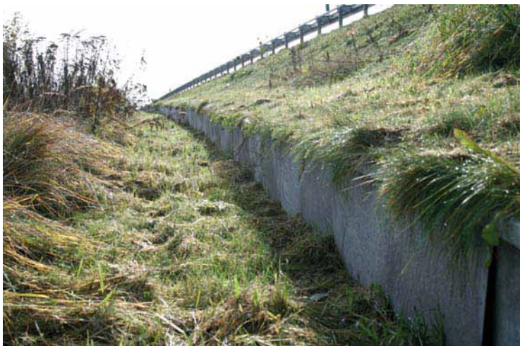
Фото 51. Залишення зкошеної трави на доріжці знижує ефективність огорожі та сприяє поширенню рослинності
