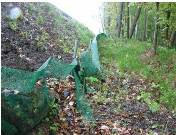
Фото 60. Наслідки відсутності контролю та ремонту огорожі на будівельному майданчику
