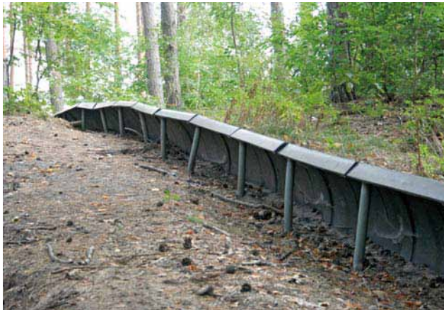
Фото 59. Тимчасова огорожа з полімерних плит (АСО) в Розточанському Національному парку
