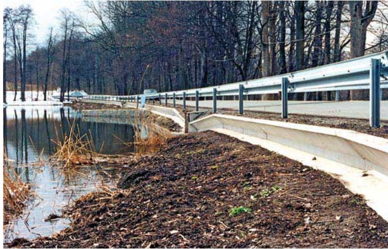
Фото 13. Бетонна огорожа, вбудована безпосередньо в насип дороги (Національний парк Столові гори)
