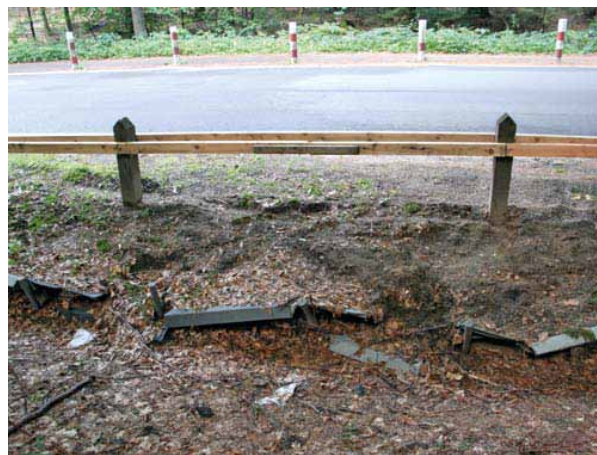
Фото 61. Збірні огорожі з полімерних панелей також пошкоджуються і вимагають ремонту
