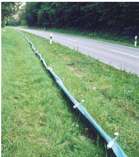
Фото 54. Огородження з полімерної плівки, що використовується під час сезонних огорож на дорогах
