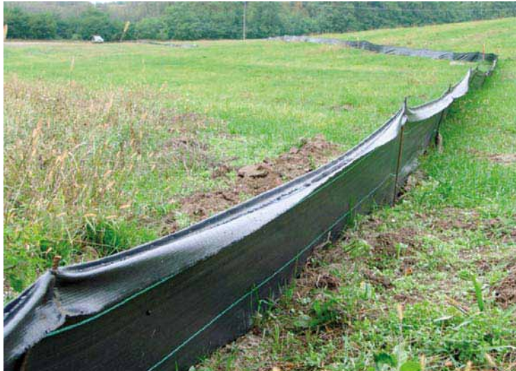
Фото 53. Тимчасова огорожа з геотекстилю навколо будівельного майданчика
