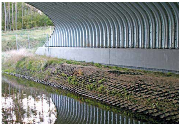
Фото 97. Геосинтетика є хорошим матеріалом для зміцнення русел річок, але необхідно щільно засипати її ґрунтом
