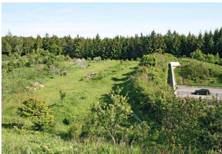
Фото 73. Приклад вигідного для земноводних облаштування верхнього переходу
