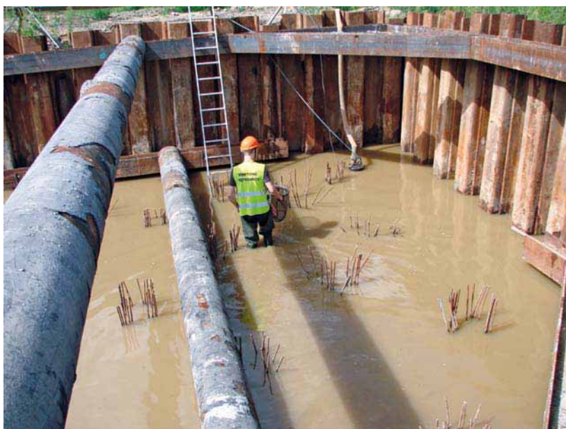
Фото 106. Важливим завданням герпетологічного нагляду є періодичний огляд усіх пасток на будівельному майданчику (тут: виїмка під опори моста)
