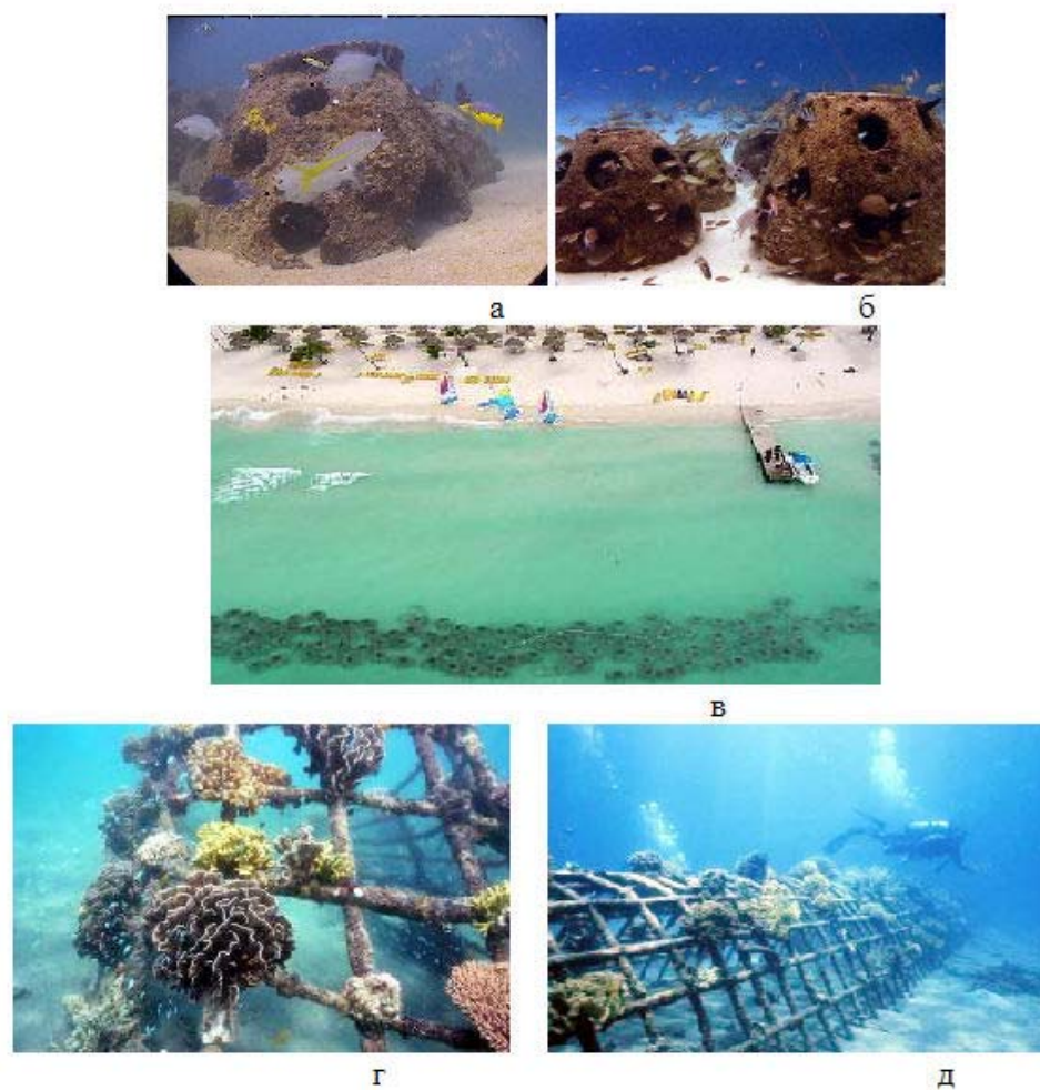
Рис. 80. Различное использование конструкций “Reef Ball” и восстановление коралловых поселений после цунами на рифах Индонезии
