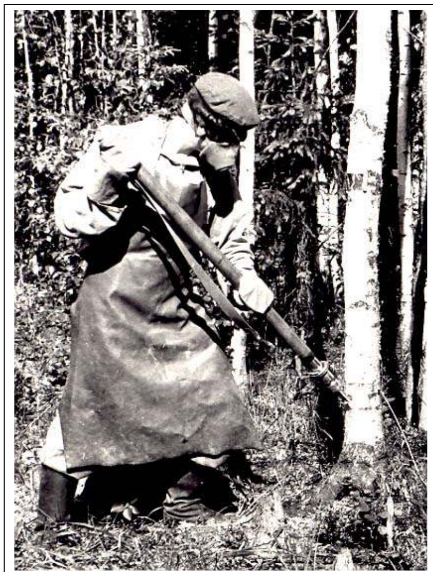
Рис. 72. Уход за елью с применением инъектора ИП-4
