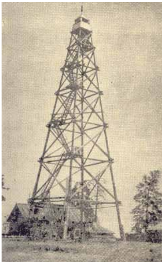
Рис. 74. Пожарная наблюдательная вышка
