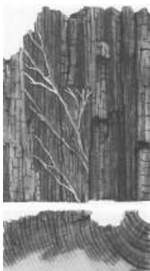
Наружная трухлявая гниль (сосна)
