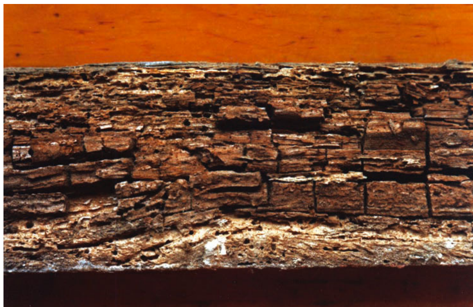
Рис. 48. Комбинированное повреждение древесины паркета (с нижней стороны) бурой гнилью, долгоносиками-трухляками и грабовым точильщиком (Ростов Великий).
