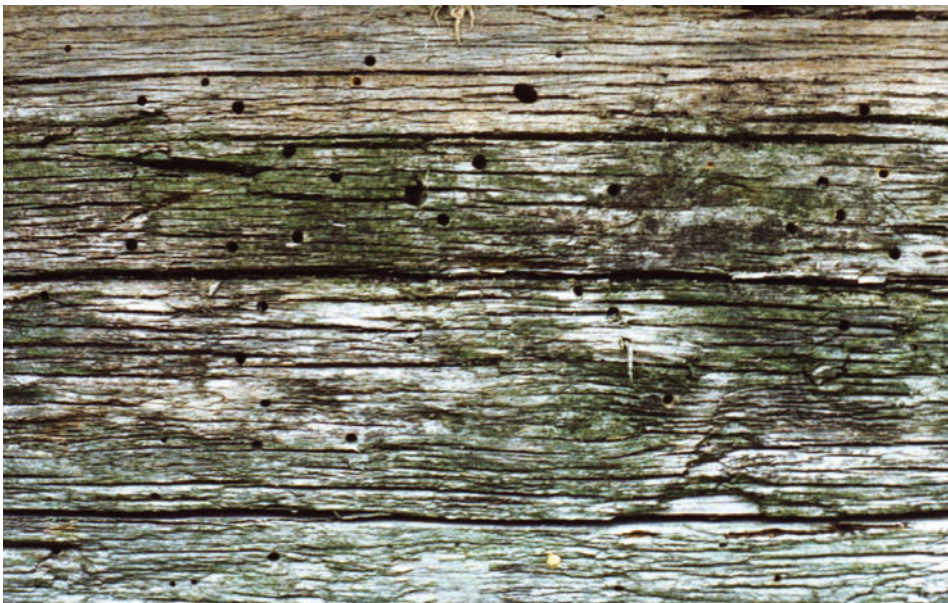
Рис. 18. Участок венца северной стены крестьянской постройки с лётными отверстиями точильщиков и усачей.
