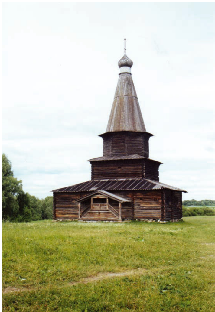
Рис. 51. Деревянная церковь (Новгородская обл.) с очагами долгоносика-трухляка.
