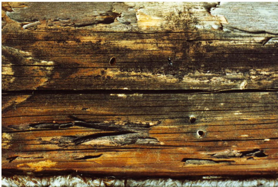
Рис. 37. Восточная стена крестьянской избы с лётными отверстиями деревянного усаха (Костромская обл.).
