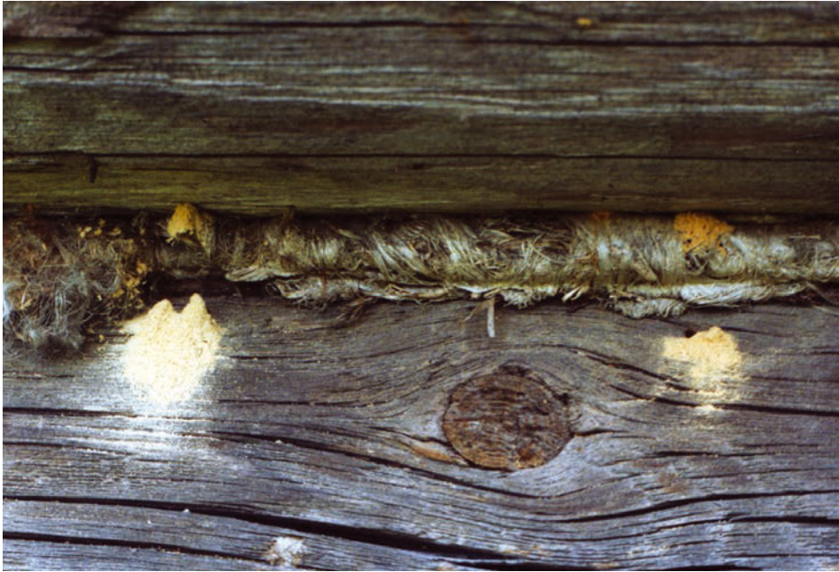
Рис. 10. Осыпи буровой муки из лёгных отверстий домового точильщика (Костромская обл.).
