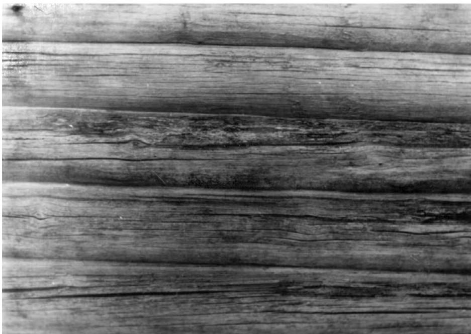
Рис. 52. Венцы церкви с очагами долгоносика-трухляка ринкола подземельного.
