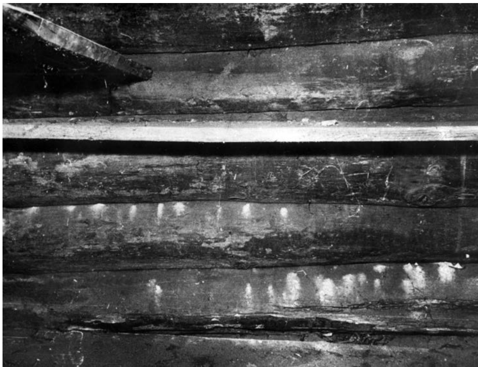
Рис. 24. Очаг ребристого точильщика в венцах бани на сваях (Кострома).
