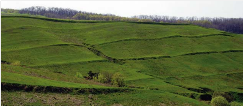
Рис. 45. Протиерозійні вали в балці біля с. Дударі Миронівського р-ну (№12-32)
