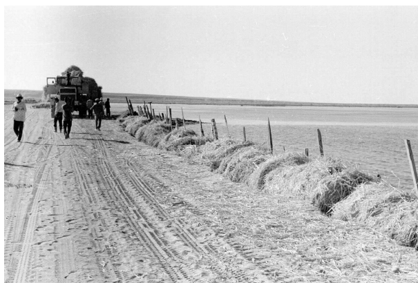
Рис. 2.5. Строительство первой плотины в проливе Берга.
