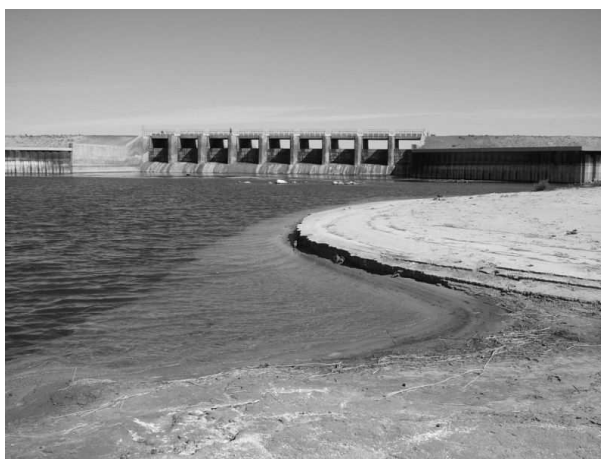
Рис. 2.9. Водопускное сооружение Кокаральской плотины (вид со стороны сбросного канала).
