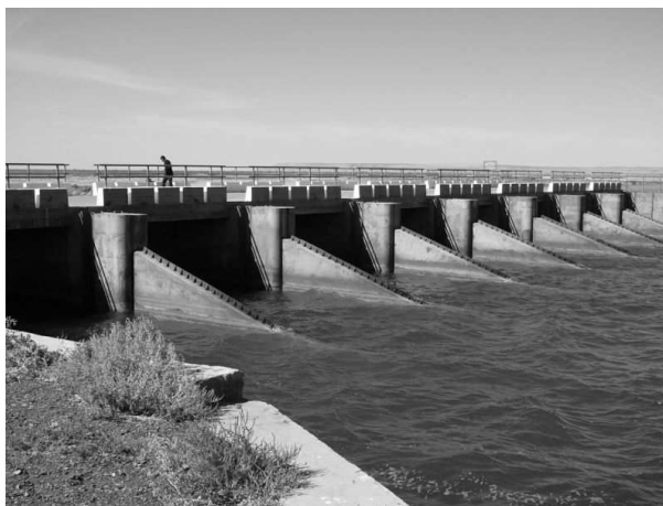
Рис. 2.8. Водопускное сооружение Кокаральской плотины (вид со стороны Малого Аральского моря).
