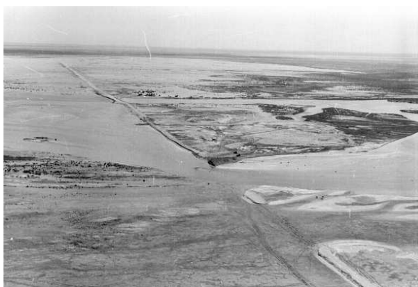
Рис. 2.6. Разрушение первой плотины в проливе Берга.
