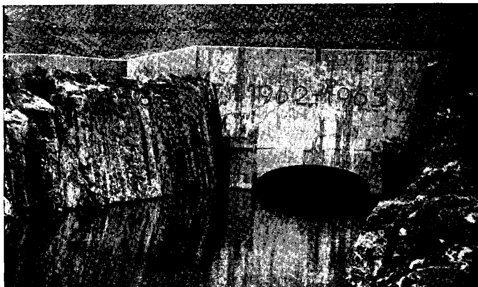
Рис. 81. Туннель Верхнетуломской ГЭС.
