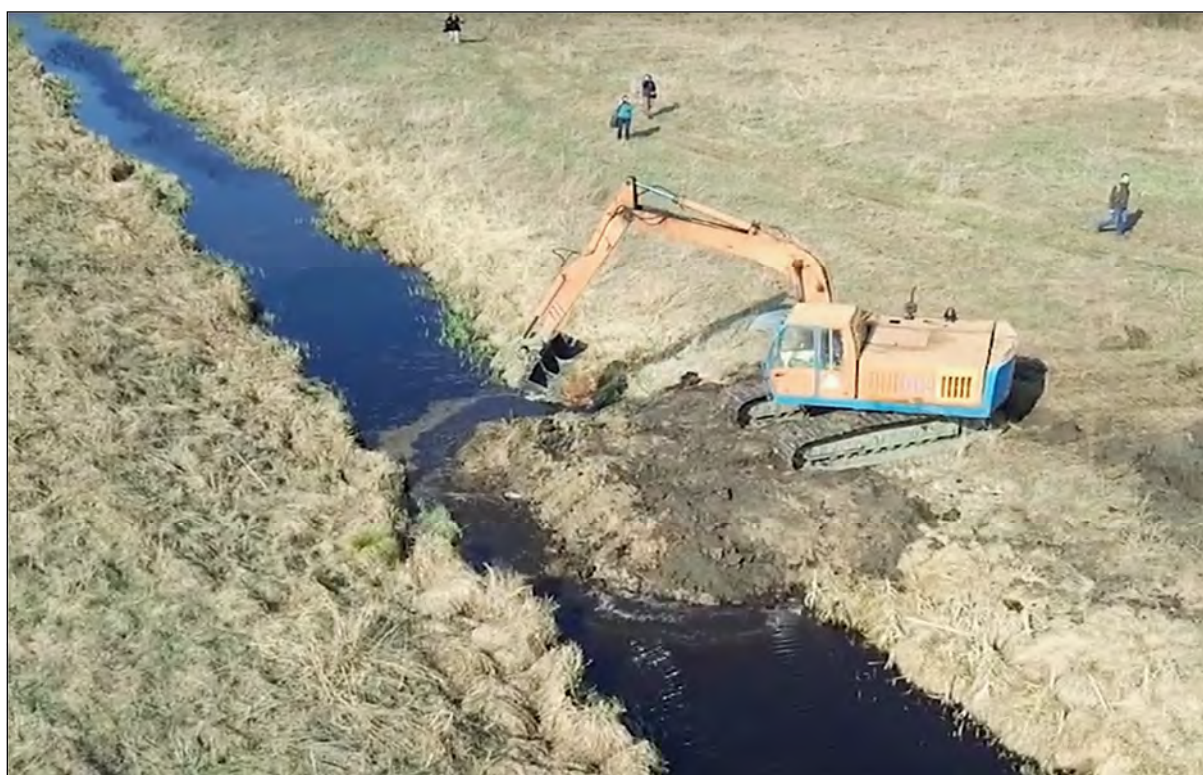
Рисунок 3.14 – Устройство каскада земляных перемычек на каналах мелиоративной системы «Верховье реки Ясельда» для снижения ее дренирующего воздействия на экосистемы водно-болотного угодья «Болото Дикое»
