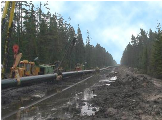
Рис. 8.45. Прокладка трубопровода в тайге
