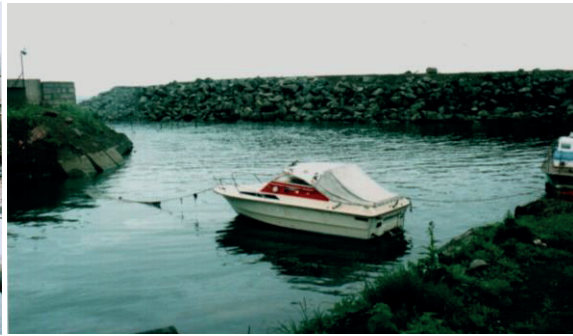
Рис. 26. Вход (канал) в водозаборный ковш.
