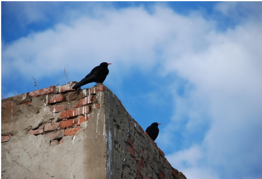
Рис. 60. В этом недостроенном кирпичном здании в с. Ринчинлхумбэ в Дархатской котловине гнездились скалистые голуби, деревенские ласточки и клушицы (июнь, 2009 г.)
