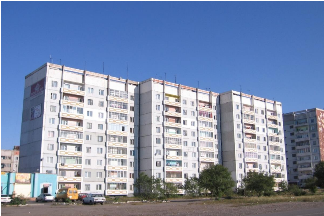
Рис. 11. Фрагмент зоны многоэтажных зданий в городе Кызыл
