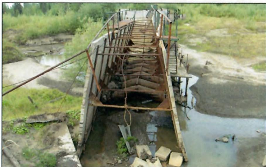
Рис. 8. Усинское месторождение, 2008 г. Зброшенная нефтеулавливающая дамба на руч. Безымянный-1. Фото М.Д. Туманова
