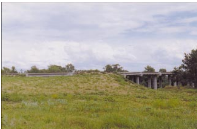
Общий вид пролета с опорой на «подушку» с запада
