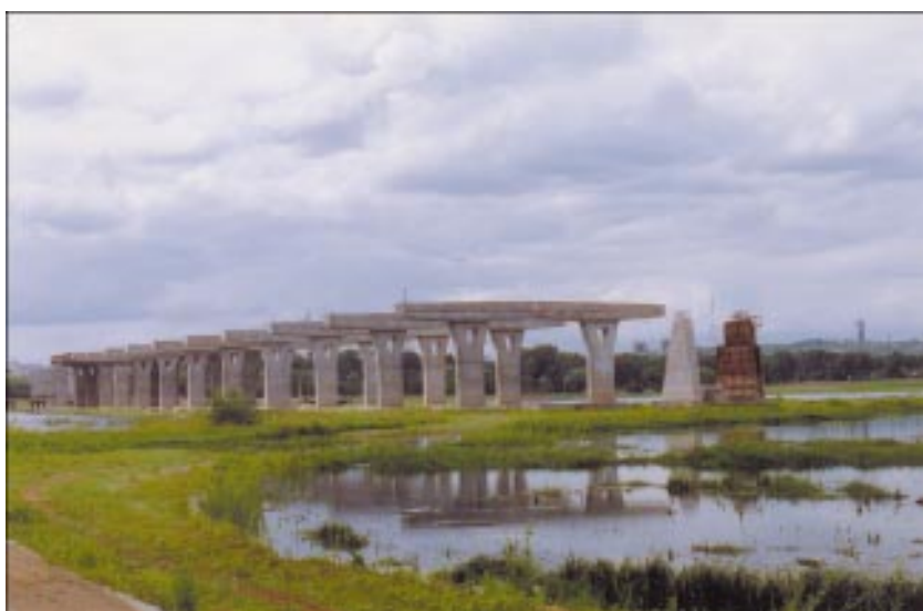
Участок моста на о. Крит. Только здесь, на разрезе между затоном (слева) и озером Денежным (справа), смонтированы траверсы на опорах. Большой сброс воды через ГЭС в июле 2004 г. Вода вышла на луговину
