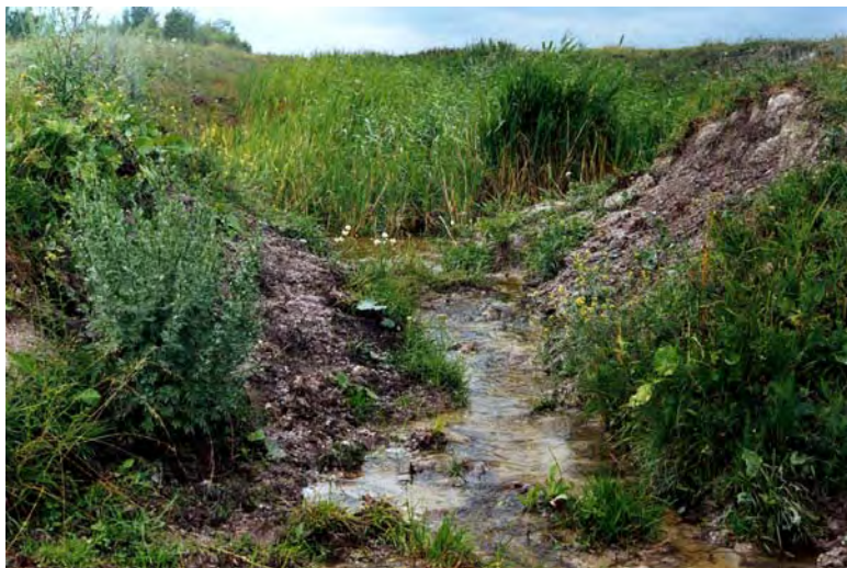
Рис. 72. Залишки ґрунтової греблі, яка до 2000 р. підтримувала належний рівень води на території Охотин-Комарівського озерно-болотного комплексу
