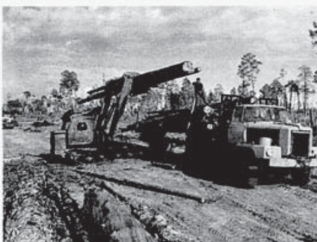
Рис. 6.6. Покорение тайги. Западная Сибирь. Сверху - вниз: сооружение газопровода; лесозаготовки
